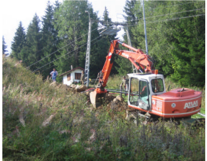
Erdarbeiten am Neubauer Skilift
